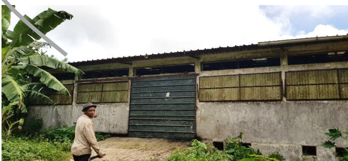
Figure 25. Bâtiment de stockage collectif de Badasambini (Diboïni/Ivembéni).
