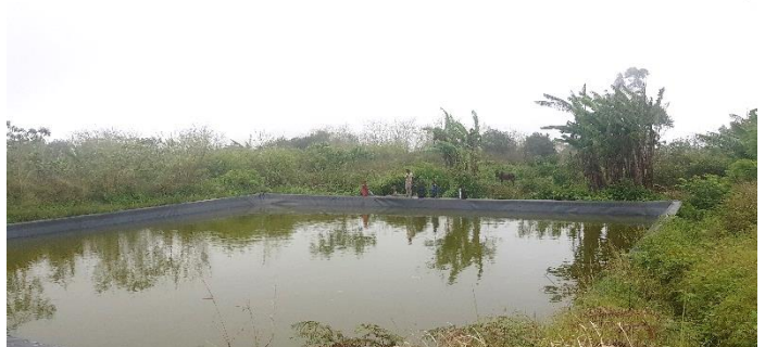
Figure 26. Bassin de rétention à Dimadjou.
