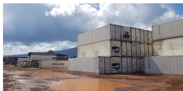
Figure 16. Dépôt de conteneurs réfrigérés au port de Moroni.
