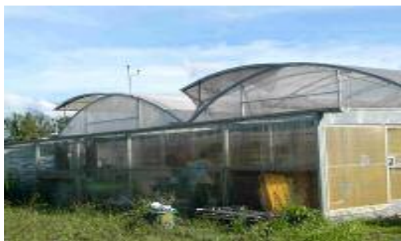
2004-2006 : Serre bi-chapelle en polycarbonate type ondex. Pépinières P.F.O., Tampon, Alt 400 m
